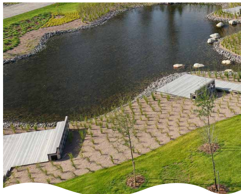
Hulevesialtaat Puustellinpuistossa Kuva: Tuomo Halmetoja
